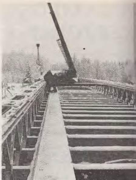
Jääkäriprikaatin pioneerit kokoavat Acrow Panel -kalustosillan Kitisen yli Moskuvaaran kyläisiä palvelemaan. Työ tapahtui TVL:n toimeksiannosta.
